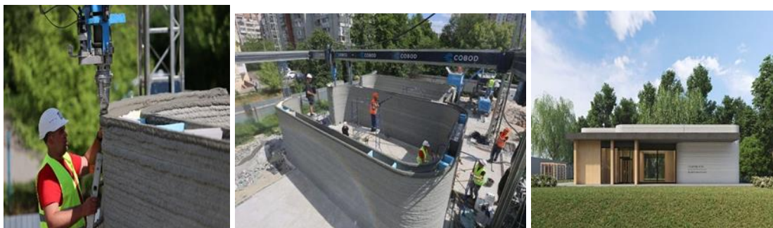
Рисунок 2 – Будівництво школи за новою технологією 3D принтера
