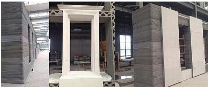
Рисунок 1 – Процес будівництва школи за новою технологією 3D принтера
