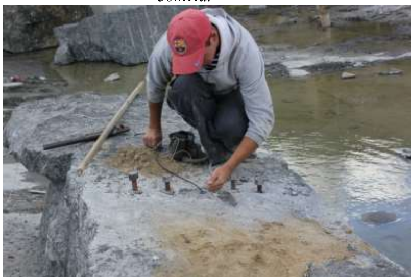
Рисунок 4. Підключення електромережі до піропатрону «Літокол».
